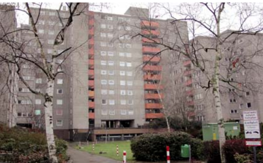
9 Sanierungsobjekt in der Berliner Rathausstraße
